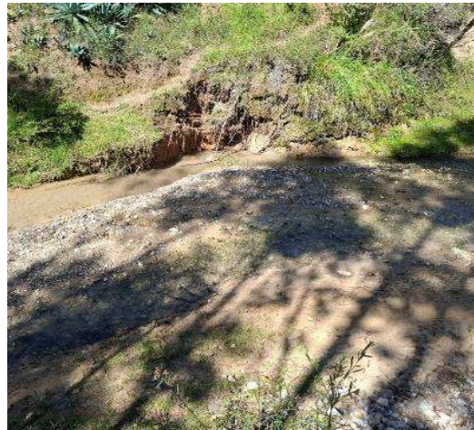
IMAGEN 02: SE MUESTRA COLMATADO EL CAUCE DE LA QUEBRADA CHAQUILMAYO CON EROSION EN LA MARGEN DERECHA SIENDO NECESARIA LA INTERVENCION CON MANETNIMIENTO ANTE UNA MAXIMA AVENIDA
