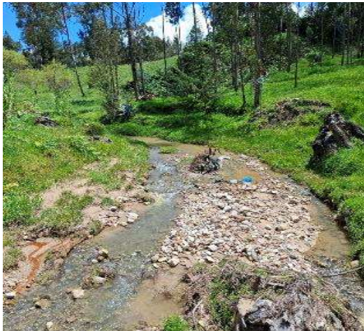
IMAGEN 01: SE MUESTRA EL ESTADO ACTUAL DEL CAUCE DE LA QUEBRADA CHAQUILMAYO SE REQUIERE LIMPIEZA DE CAUCE Y PROTECCION EN AMBAS MARGENES PARA EVITAR LA EROSION Y MITIGAR INUNDACIONES
